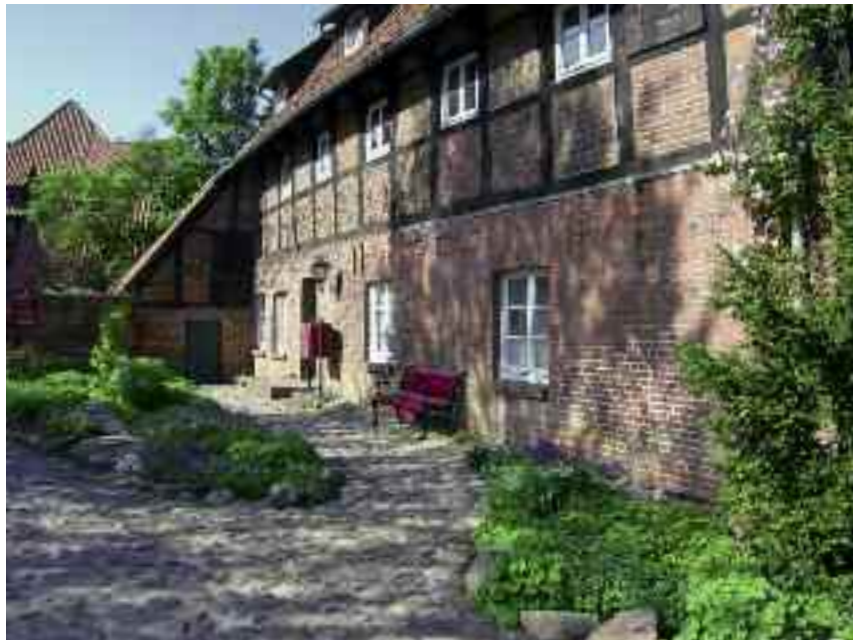
Das ehemalige Mühlengebäude am Kloster Lüne (als Bestandsgebäude seit 2009)
