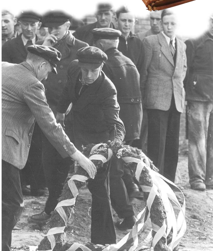
Eine Richtkrone für die Ersatzbauten in der Wedekindstraße und Hinter den Scheibenständen.
