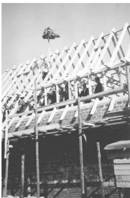
Richtfest für das eigene Bürogebäude am Lerchenweg 1952.
