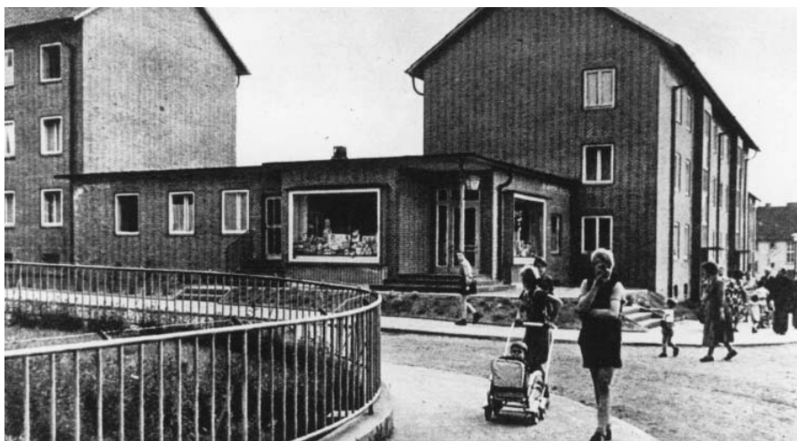
Ersatzwohnungen für Opfer der Senkungsschäden
