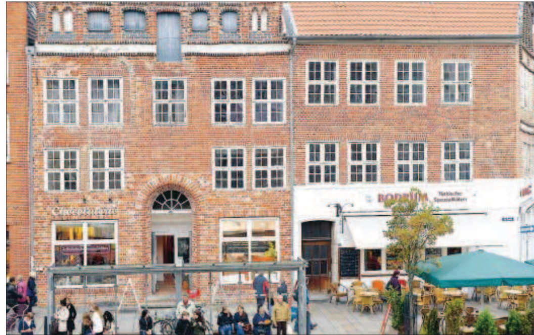
Die toten Augen der Innenstadt: Leere Fenster und dunkle Räume wie hier am Sand belegen, dass obere Etagen von Geschäftshäusern häufig nicht genutzt werden. Statt Wohnraum zu schaffen, vermieten Besitzer lieber das gesamte Haus an Ladenbetreiber – und die brauchen oft nur das Erdgeschoss. Foto: t & w
