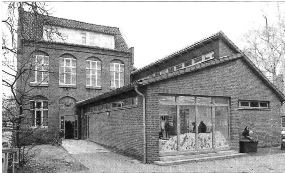
Auf dem Gelände der ehemaligen St.-Ursula-Schule plant die Lüwobau 30 Seniorenwohnungen.
