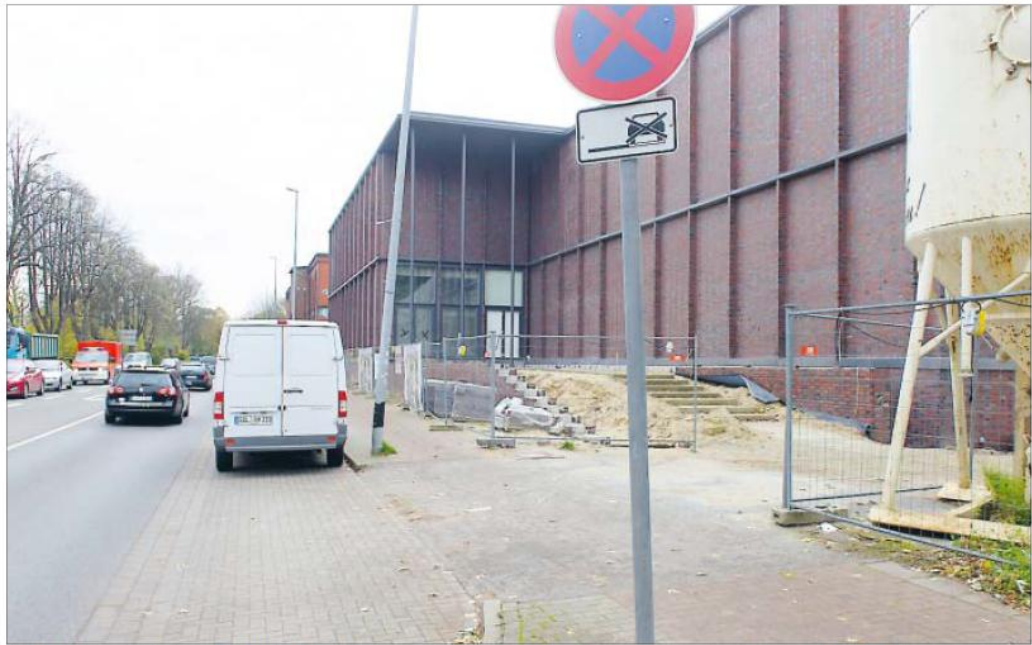
Die Parkplätze für Autos an der Willy-Brandt-Straße direkt vorm Museum sollen im kommenden Sommer zu Busparkplätzen umgestaltet werden, sodass Museumsbesucher dort aus- und einsteigen können. Foto: t & w
