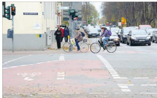
Die Fahrbahn im Kreuzungsbereich der Altenbrückertorstraße soll saniert werden. Im Zuge dessen soll auch die Aufstellfläche für Radfahrer auf der Seite zum Pizzaladen hin verbreitert werden. Foto: t & w
