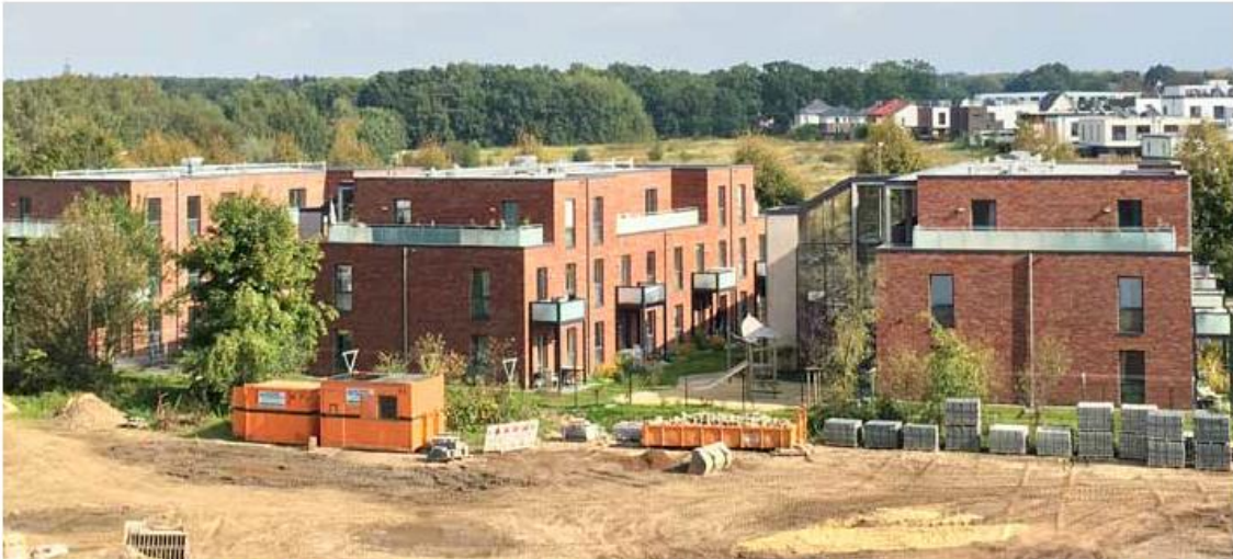
Die Lüwobau stellte im Herbst 2016 zwei Gebäude am Meisterweg fertig, in diesem Jahr ist ein weiteres hinzugekommen. Foto: Lüwobau
