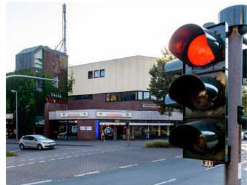
Ortsbildprägend ist die Ecke Lindenstraße/Barckhausenstraße. Das Gebäude mit dem Bowling-Center soll abgerissen werden. Foto: t&w
