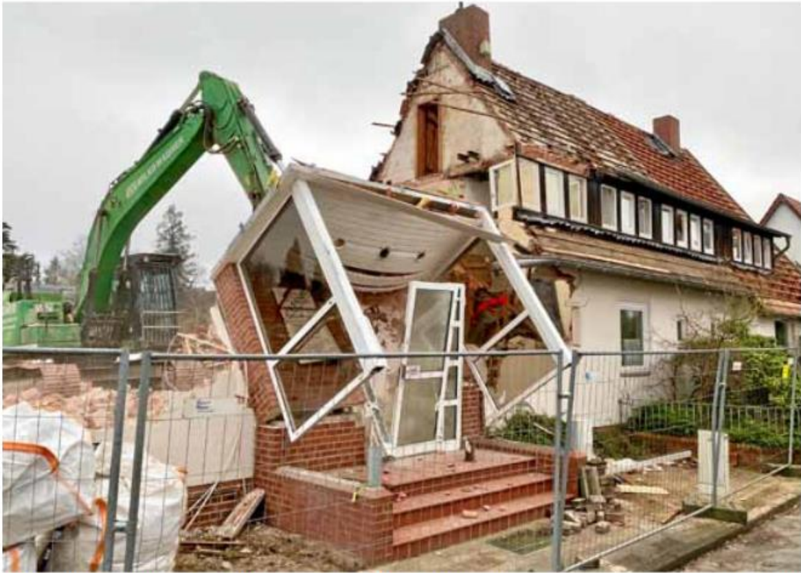
Der Bagger hat wenig Mühe mit dem alten Gebäude der Lüwobau.
