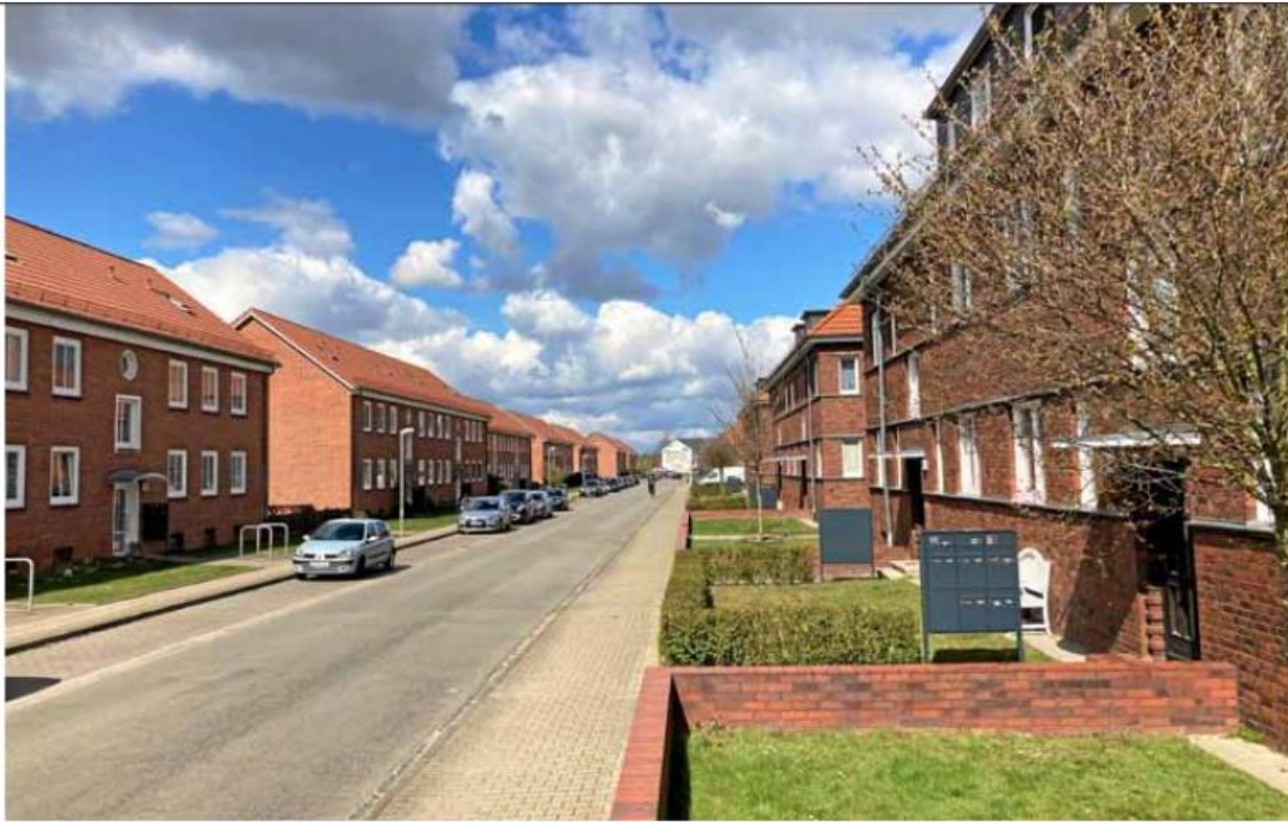
In der Ringstraße wurden 166 Wohnungen an ein neues Nahwärmenetz und eine neue Heizzentrale mit Biomethan-Blockheizkraftwerk angeschlossen.
