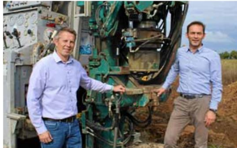
Machten sich gemeinsam ein Bild von der Baustelle: Harald Gründel, Projektleiter der Avacon Natur (l.), und der städtische Nachhaltigkeitsdezernent Markus Moßmann. Foto: Stadt Lüneburg
