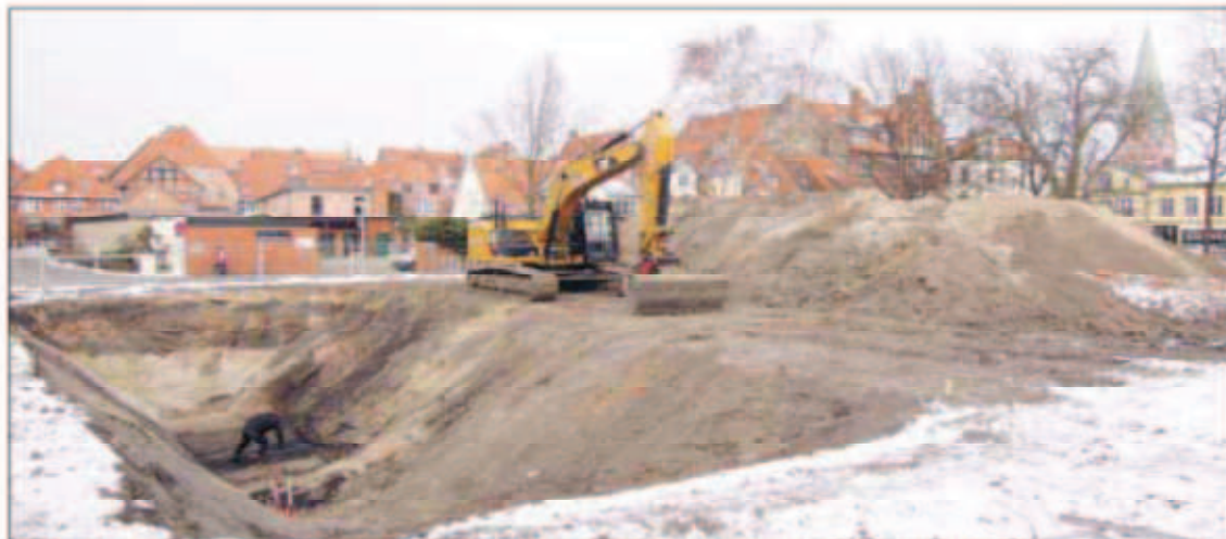
Trotz frostiger Witterung gehen die Arbeiten auf dem Areal an der Ecke Wallstraße/Rote Straße weiter. Die Lüwobau will hier Wohnungen für Senioren bauen.
