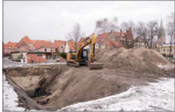
Die Baustelle für die Seniorenanlage auf dem Gelände der ehemaligen St. Ursula Schule.
