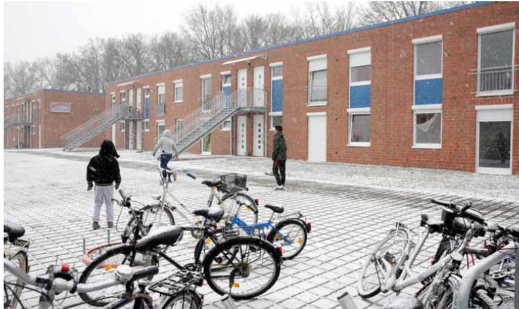
Zu Hochzeiten gab es 14 Gemeinschaftsunterkünfte für Flüchtlinge im Lüneburger Stadtgebiet. Dazu zählen auch diese Neubauten in Oedeme. Inzwischen hat die Stadt sieben Einrichtungen wieder abgebaut. Foto: t&w
