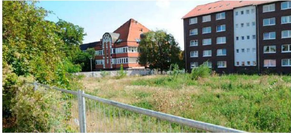
Auf dem derzeit brachliegenden Grundstück an der Soltauer Straße will das DRK Lüneburg eine Seniorenwohnanlage errichten. Foto: be
