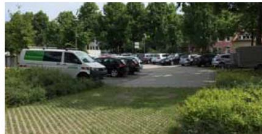
Sülztorstraße: Teil-entsiegelter und verschatteter Parkplatz.
