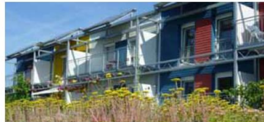
Beispiel für Dach- und Fassadenbegrünung.
