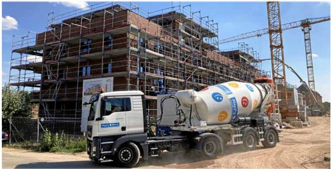
Die Arbeiten für den Neubau an der Carl-Gottlieb-Scharff-Straße im Hanseviertel-Ost laufen auf Hochtouren. Die Wohnungen werden größtenteils nur an Bürger mit Wohnberechtigungsschein vermietet. Foto: Lüwobau
