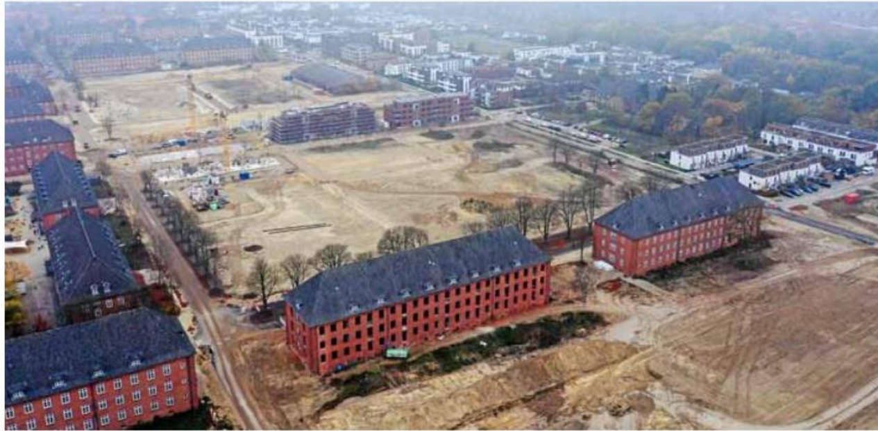
Ein Blick von oben auf das Hanseviertel Ost: In den Bestandsgebäuden im Vordergrund sollen Wohnungen mit Mietpreisbindung entstehen, weiter hinten erstellen Lüwobau und die Wohnungsgenossenschaft geförderten Wohnungsbau.
