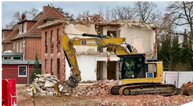
Die Gebäude stammen aus der Zeit des deutschen Wirtschaftswunders in den 1950er-Jahren und waren typische Wohnungsneubauten für diese Zeit. Jetzt reißt sie ein Bagger ab. Foto: Boldt
